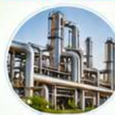
Calor e Vapor Industrial
