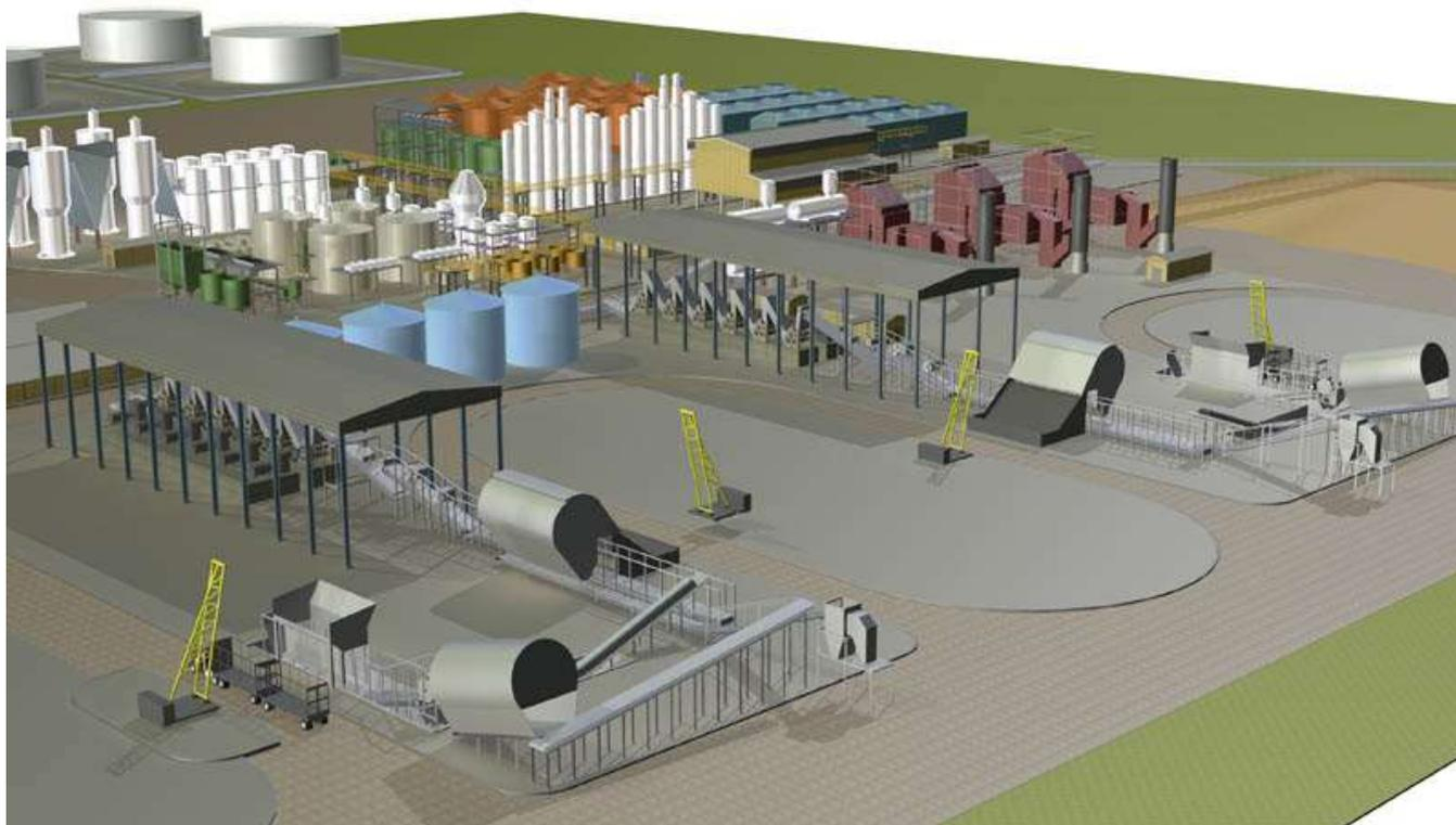
A Brasil Biomassa foi contratada pela Building da Itália para atuação consultiva no Projeto MKUZE – África do Sul palha da cana de açúcar para o processo de geração de energia térmica. A nova central Mkuze seguirá a legislação sul-africana de “Small Scale Boilers”, a qual impõe uma limite de 50 MWt PCI de entrada com uma central de energia. Avaliando o sistema de caldeira industrial, limpeza a seco da palha, enfardamento e energia com o uso da palha.
