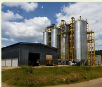
PLANTA INDUSTRIAL DE PELLETS – CAÇADOR/SC
